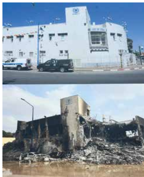
Das obere Bild zeigt die Polizeistation in Sderot vor dem bestialischen Überfall der Hamas am 7. Oktober 2023, das untere Bild die Überreste dieser Station nach dem Überfall.
